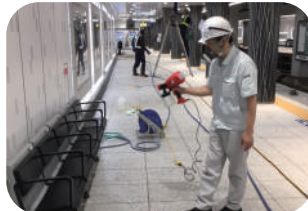
東京メトロ 駅構内
